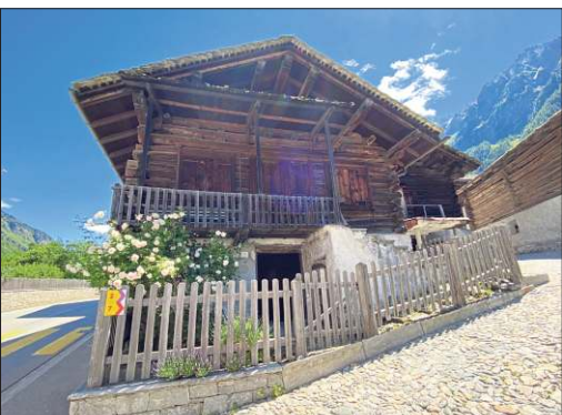
Einen alten Stall hat Giacometti zum Atelier umgebaut.
