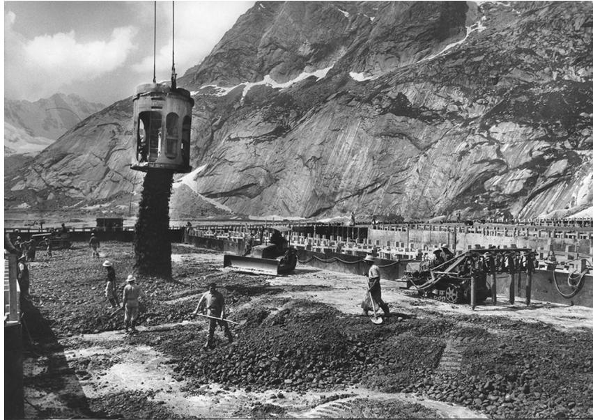
*Die Staumauer baut man aus Beton, mit riesigen Hohlräumen im Innern des Bauwerks*
